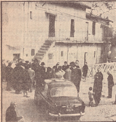
Agenti e vigili urbani convincono le famiglie ad abbandonare la palazzina pericolante al Pigneto
