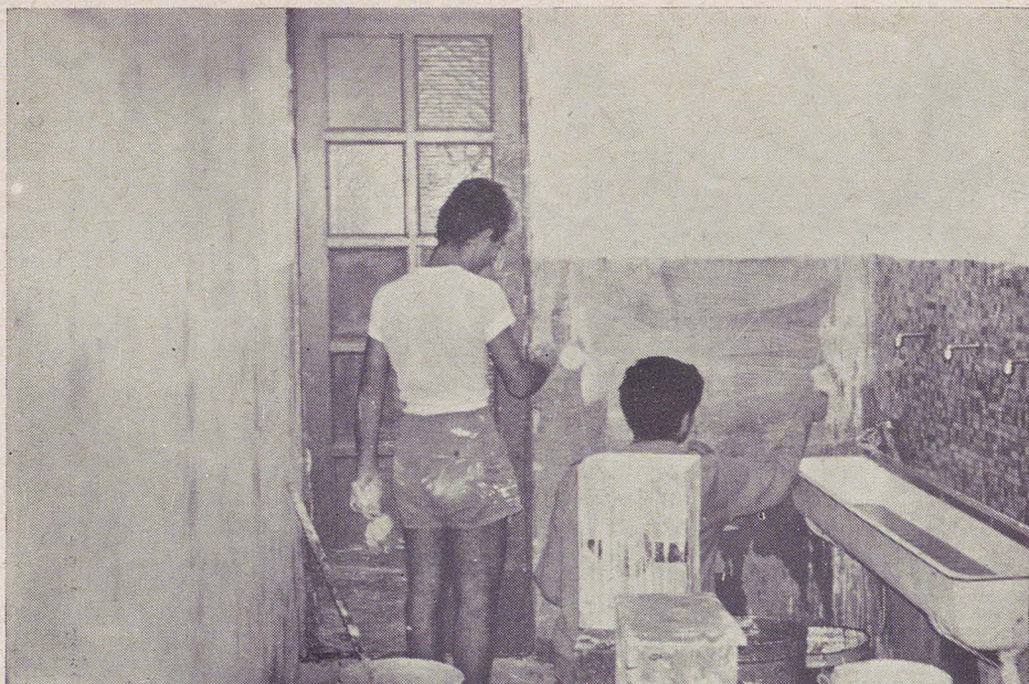
Campo di Signa - Uno dei diversi lavori di sistemazione interna al Villaggio scolastico artigiano: si lavora alla tinteggiatura.
